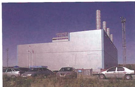
ГТ ТЭЦ-009МЭ, г. Ревда
